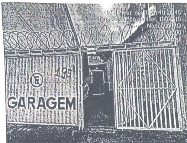
Fachada do imóvel vistoriado
